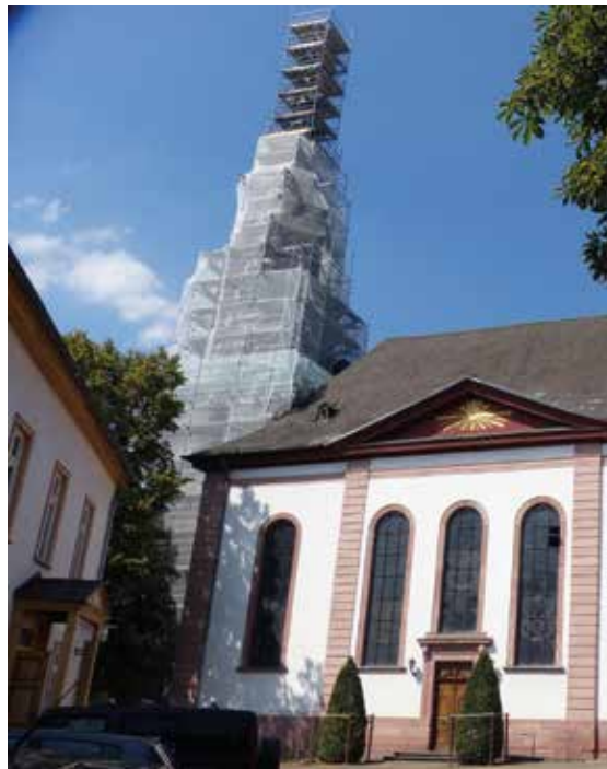
St. Peter und Paul in Bad Camberg (Kirchturm und Sanierung Kirchenfenster)
