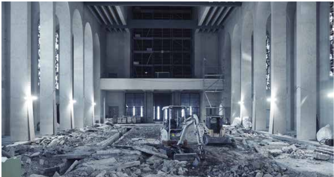
Pfarrkirche Frauenfrieden in Frankfurt (Instandsetzung und Innenrenovierung)
